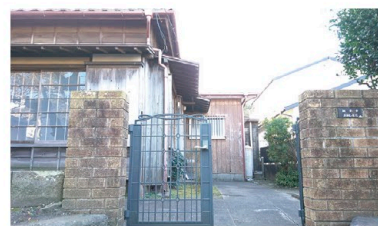
市が整備したお試し住宅
