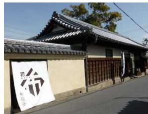
(例)歴史的建造物の修理・買取
