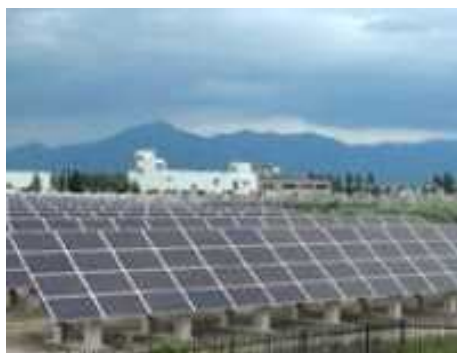
山形県 山形浄化センター
