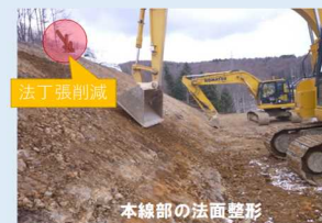
本線部の法面整形
