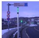
視認性を向上させるためLEDを付加した自発光式の視線誘導標
