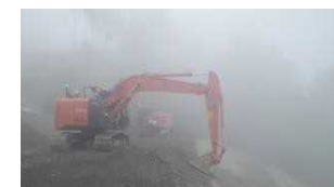
濃霧条件下での施工状況
