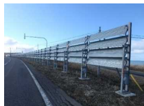
防雪柵の整備
