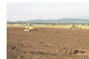
整地工の状況
