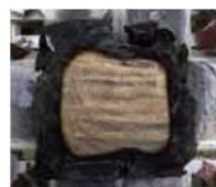
燃焼後の太い柱
