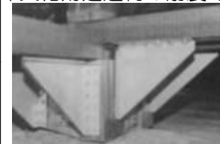
床下ダンパーの設置
