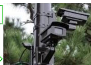
自動首振り式放水銃の設置
