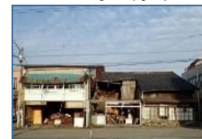
空き家の除却
