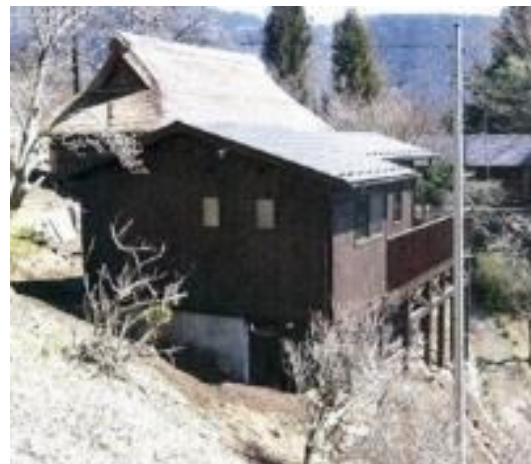
<例>重要文化財建造物 東京都 小林家住宅の来訪者用便益施設
