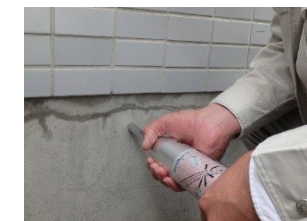
リバウンドハンマーを用いた コンクリートの圧縮強度の測定
