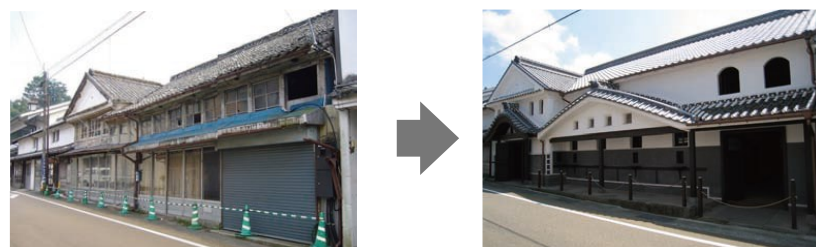
「佐藤家住宅旧店舗兼主屋ほか」（大分県） 店舗兼主屋と味噌蔵として登録された2件の建物を郵便局として建築された明治時代の姿に復原。近世から近代へと受け継がれた城下町竹田の変遷がうかがわれる。現在は公開施設等として活用。
