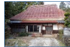
空き家の活用
