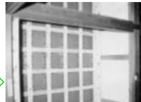
押入れ部分に耐震壁を設置
