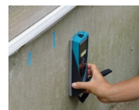
基礎配筋の調査
