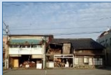
空き家の除却
