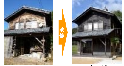
改修前(空き家) 改修後(グループホーム、飲食店、宿泊施設等)
