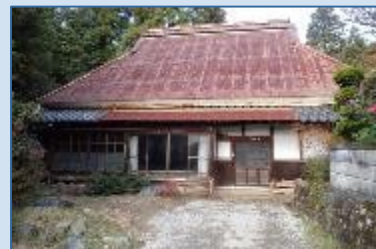
空き家の活用
