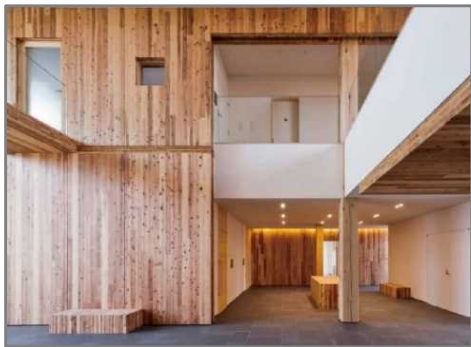
構造部材を「あらわし」としている 高知県森連会館 (2階建の事務所※)
