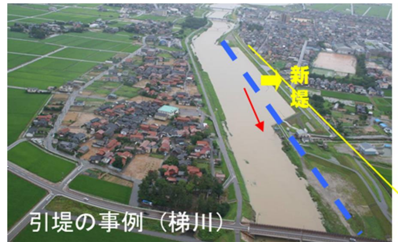
引堤の事例(梯川)
