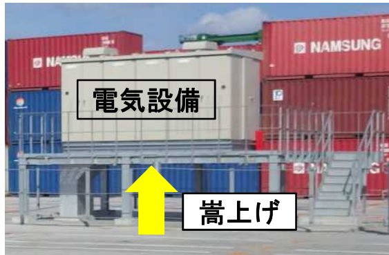
電気設備の嵩上げ事例
