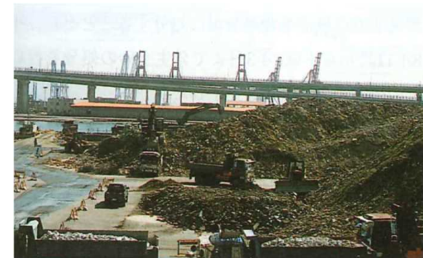
ガレキの積み出し基地(灘浜基地)
