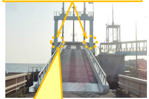
部材が接触し、上下操作が不可 (4/20に復旧)
