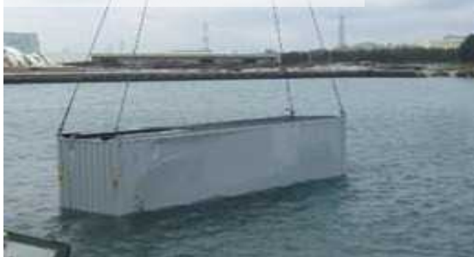
航路の啓開作業(コンテナの引き揚げ)
