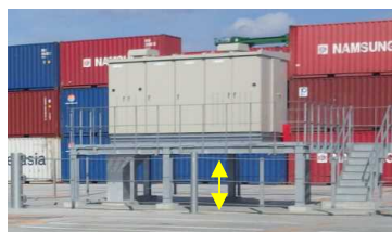
電気系設備の嵩上げ
