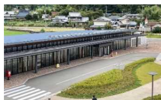
能勢町庁舎 （庁舎屋上に太陽光発電設備が設置されている） 出所：調査時撮影
