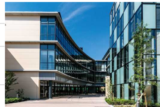
低炭素型複合施設 「キセラ川西プラザ」 出所：川西市HP
