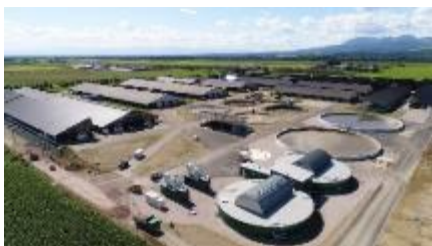
バイオガスプラント
