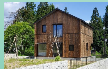
山形県の高断熱省エネ住宅
