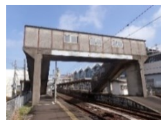
既存施設 の撤去
