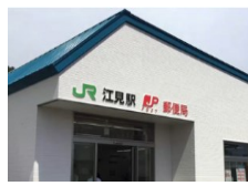
駅舎の 新改築・移設
