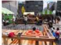
ストリートウッドデッキ（SWD） 構造、製作と実験的設置
