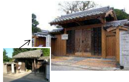
ワンコイントラスト（寄付）で修理が実現した井上勝邸旧門
